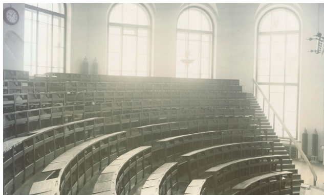
Аудитория главного корпуса с действующими радиаторами отопления (© Музей истории СПбПУ, 1902 г.)
