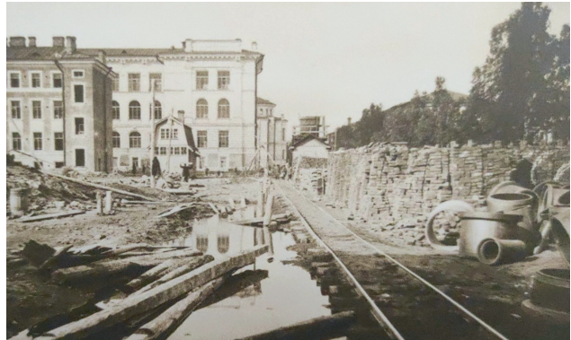
Строительство химического корпуса (© Музей истории СПбПУ, 1901 г.)
