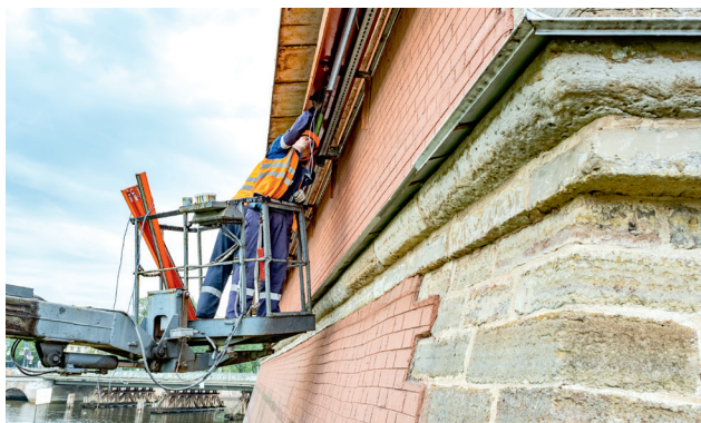
Установка люминесцентных ламп на участок крепостной стены (© СПб ГБУ «Ленсвет», 2023 г.)
