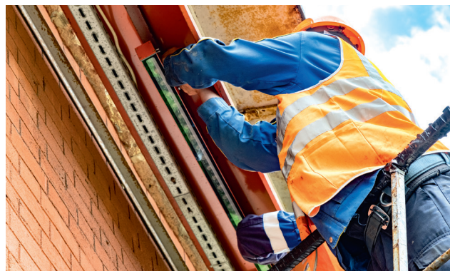
Установка люминесцентных ламп на участок крепостной стены (© СПб ГБУ «Ленсвет», 2023 г.)
