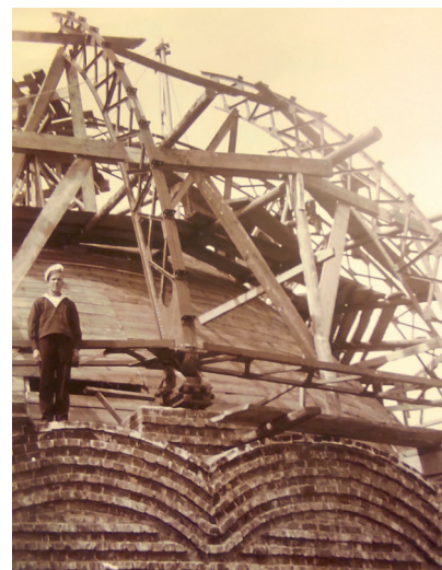
Строительство главного купола (© ФГБУ «ЦВММ» Минобороны России, 1908 г.)
