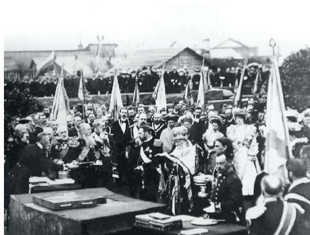
Закладка фундамента будущего собора (© ФГБУ «ЦВММ» Минобороны России, 1902 г.)
